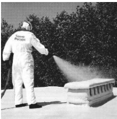
Теплоізоляція будівельних споруд, резервуарів
