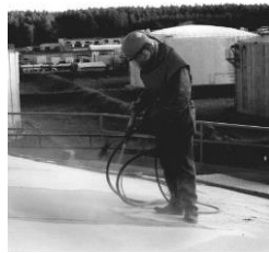
Струминна очистка поверхонь; протикорозійний захист обладнання
